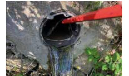
Un suivi du bon fonctionnement des ouvrages contribuant à la gestion du risque inondation est effectué annuellement par le Sagyrc. Il porte sur les clapets anti-retour et le bon état des digues. En 2023, des visites techniques approfondies ont été réalisées par des intervenants extérieurs, dans le respect de la réglementation qui prévoit ce type de contrôle tous les 6 ans.
