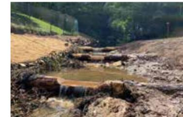
Sur le ruisseau des Pierres Rouges, à Marcy l'Étoile, en raison d'une incision du fond du lit, les berges étaient fragilisées et une canalisation visible à l'œil nu. L'installation de 3 petits seuils en bois a permis de stabiliser et de remonter le fond du lit du ruisseau et de protéger la canalisation. Les berges ont été restaurées et aménagées en pente douce.
