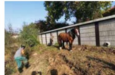
Le charruage consiste à « labourer » avec l'aide d'un cheval, les banquettes de sédiments accumulées au fil des saisons dans le lit du cours d'eau. Ce labourage permet de décompacter les sédiments, qui seront emportés naturellement lors d'un prochain coup d'eau. Cette technique est efficace : sur les secteurs traités en 2023, la section hydraulique nécessaire pour écouler une crue comme celle de 2003 reste correcte.
