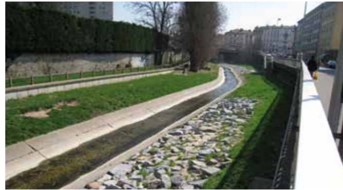
L'aménagement des cours d'eau s'est accompagné d'une restauration environnementale. Ici à Oullins, la cunette béton a été détruite et le lit de la rivière renaturé.
