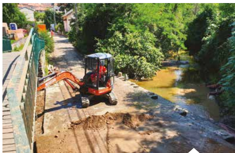
Les travaux de déviation de réseaux réalisés à l'été 2019.
