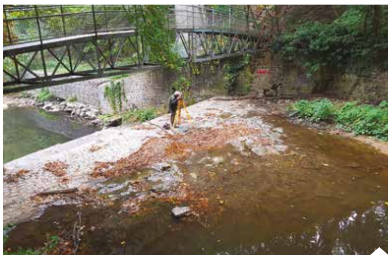
Sondages géotechniques sur le seuil de Taffignon.
