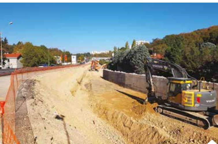
Travaux de terrassements : le nouveau profil de la rivière se dessine.
