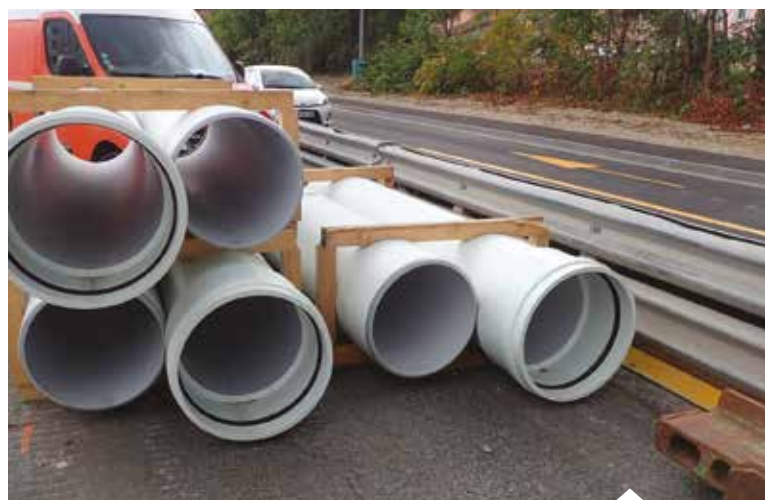
Travaux de rénovation des réseaux d'assainissement réalisés par la Métropole de Lyon.
