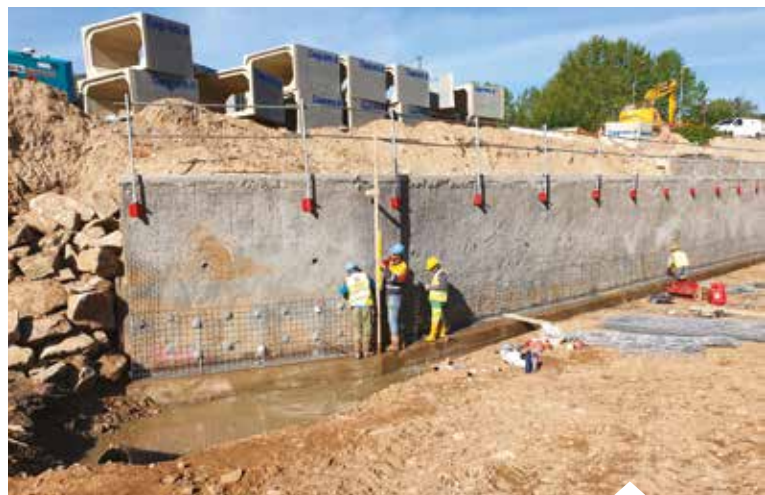
Travaux de génie civil : la pose des parois cloutées.
