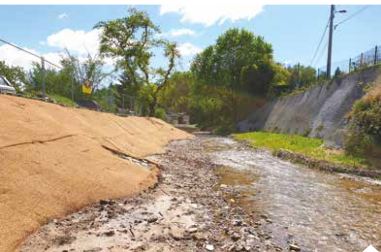
Tassin la Demi-Lune, travaux de génie écologique, été 2019
