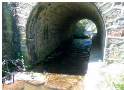
*La suppression de la « cascade » et l'aménagement d'un dispositif de remontée des poissons sous le tunnel permettront de supprimer cet obstacle à leur libre circulation.*
