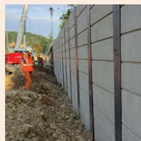
La rive gauche de l'Yzeron au niveau du quartier du Merlo est protégée par une berlinoise. Il s'agit d'un mur de soutènement et de protection hydraulique réalisé avec des pieux en métal de 9 mètres de hauteur, enfoncés aux 2/3 dans le sol, entre lesquels sont glissés des plaques de béton. Ces berlinoises, décorées d'un motif végétal, seront habillées de plantes grimpantes.
