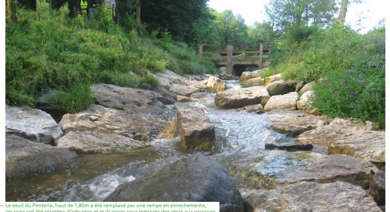
Le seuil du Ponterle, haut de 1,80m a été remplacé par une rampe en enrochements, les rives ont été plantées d'arbustes et le lit repris pour ménager des abris aux poissons.
