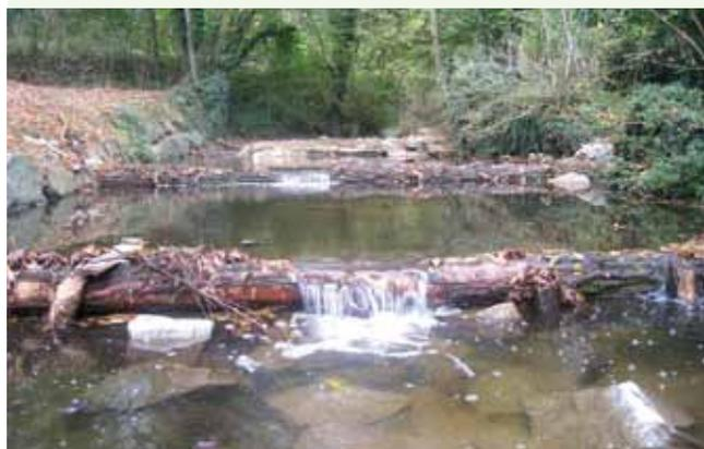
— Exemple de fractionnement de chute à l'aide de pré-barrages à Charbonnières-les-Bains
