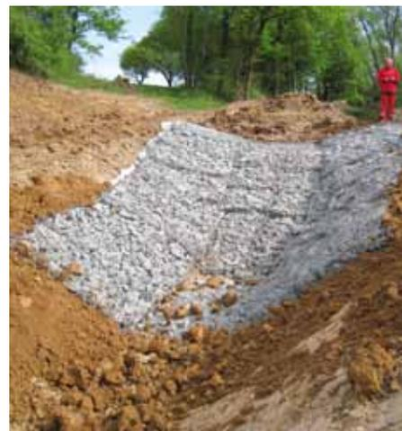
Le renforcement du lit avec la pose de gabions
