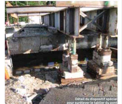
Détail du dispositif spécial pour surélever le tablier du pont
