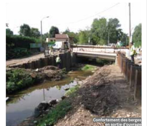
Confortement des berges en sortie d'ouvrage
