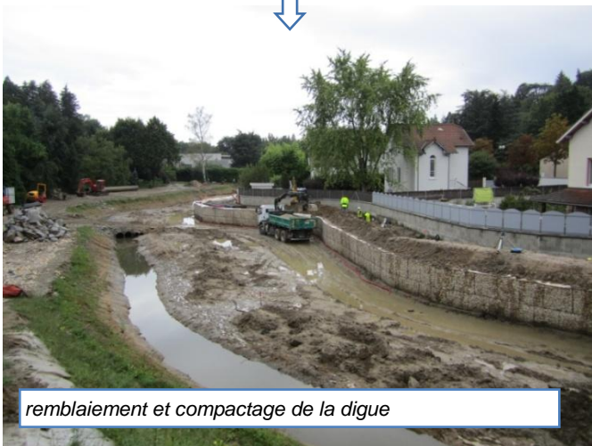
Photos 68 : Construction de la digue de Charbonnières-les-Bains
