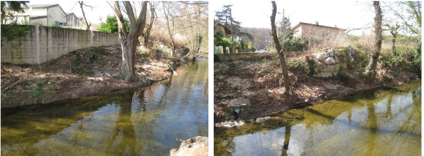
Photos 50 et 51 : Le mur digue existant au quartier des Platanes à Sainte Foy-lès-Lyon
