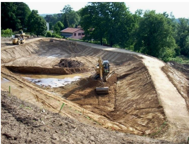
Photos 16 et 17 : Construction du bassin de rétention des Sables à Chaponost (2008) et fonctionnement du bassin des Attignies à Grézieu-la-Varenne (2007)
