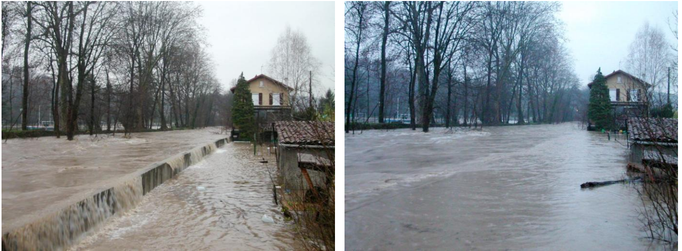
Photos 14 et 15 : Petits endiguements dépassés au Merlo à Sainte Foy-lès-Lyon lors de la crue de décembre 2003, d'ordre trentennal
