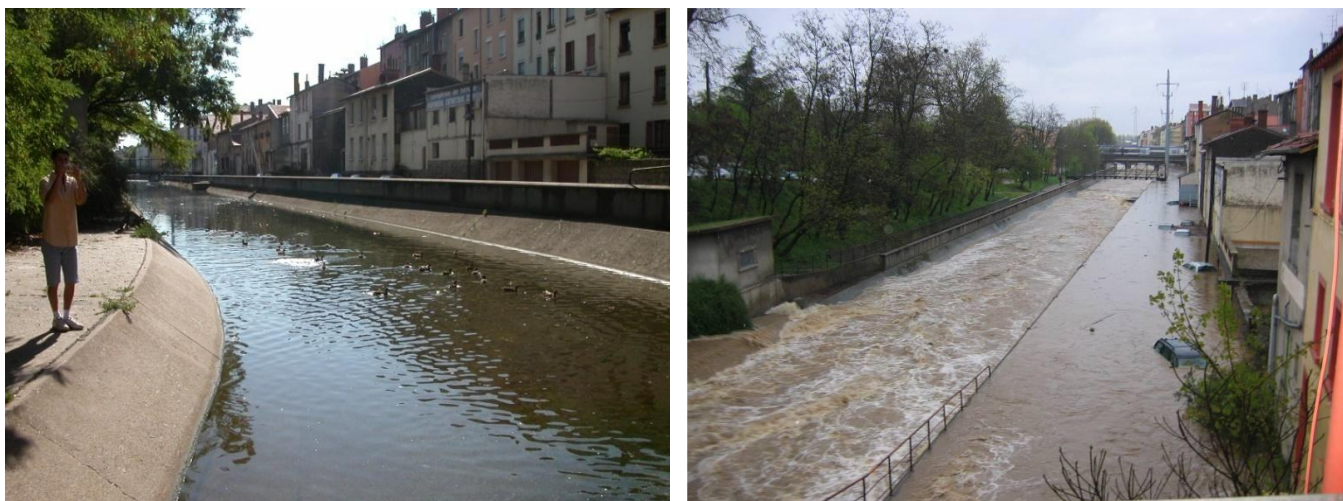
Photos 73 et 74 : Enjeux exposés et quai Sémard à Oullins inondé lors de la crue de décembre 2003
