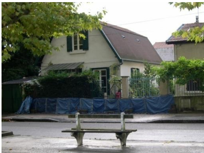
Photos 32 et 33 : Protections localisées provisoires (bâches, « hydrobags® ») utilisées à Oullins lors de la crue de novembre 2008
