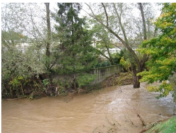
Photos 12 et 13 : Mur digue du quartier des Platanes à Sainte Foy-lès-Lyon, ayant partiellement rompu par retour lors de la décrue de novembre 2008
