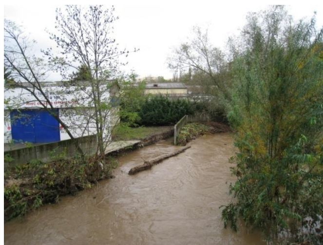
Photos 12 et 13 : Mur digue du quartier des Platanes à Sainte Foy-lès-Lyon, ayant partiellement rompu par retour lors de la décrue de novembre 2008
