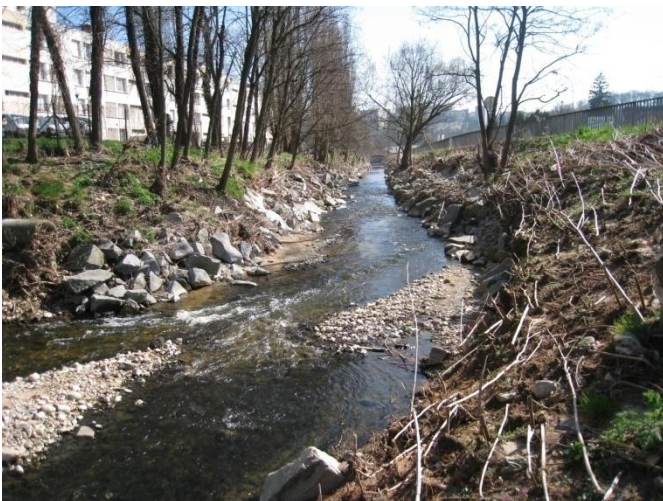
Photos 52 et 53 : L'Yzeron recalibré et trapézoïdal le long de la RD 342 à Sainte Foy-lès-Lyon
