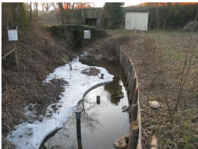
Photo 22 : Dispositif OTHU de mesure permanent sur le ruisseau de la Chaudanne à Grézieu-la-Varenne
