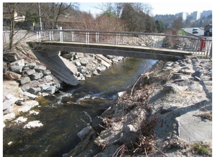
Photos 52 et 53 : L'Yzeron recalibré et trapézoïdal le long de la RD 342 à Sainte Foy-lès-Lyon
