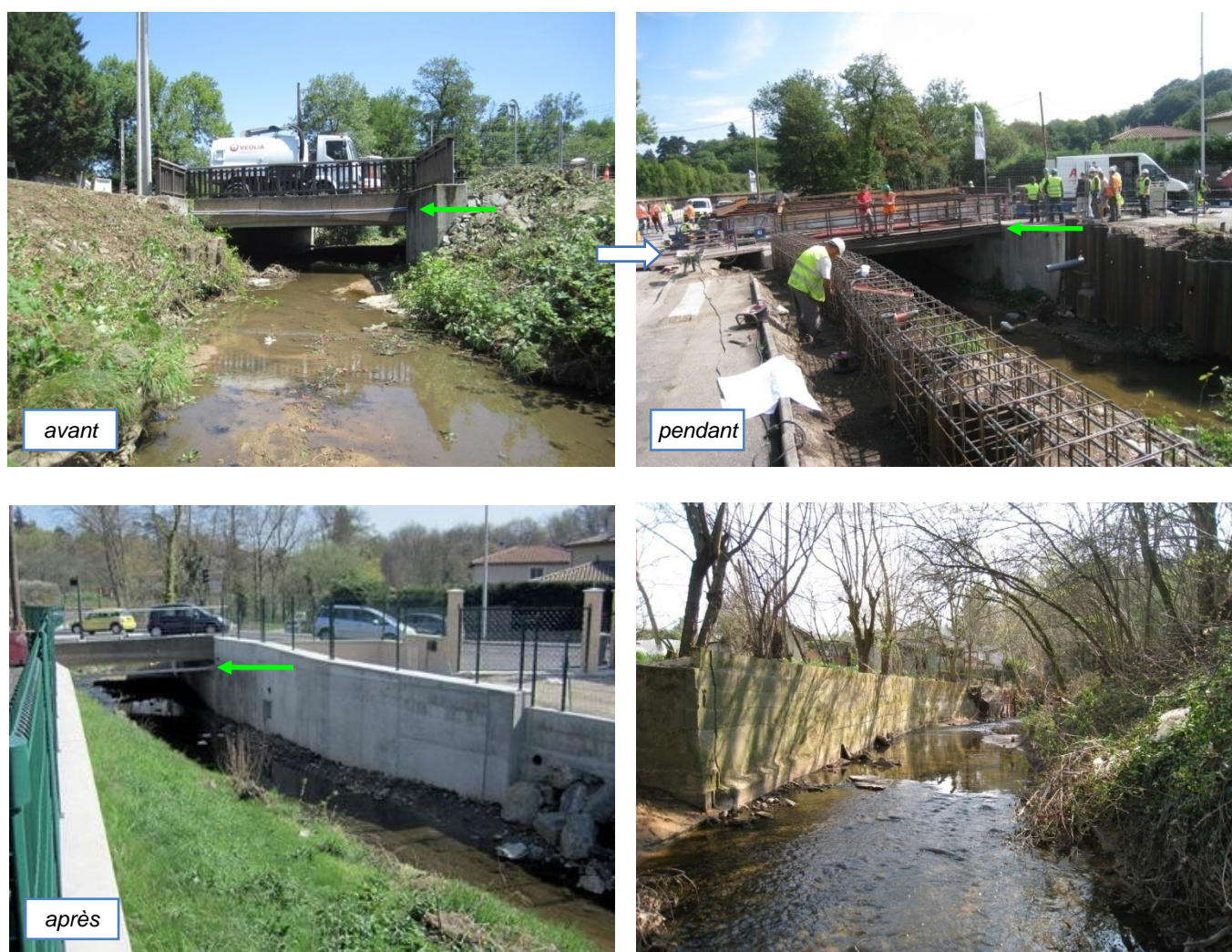
Photos 43 : Rehausse du pont des Bruyères sur le Ratier en 2012 et illustration de la configuration contrainte du site du Grand Pré
