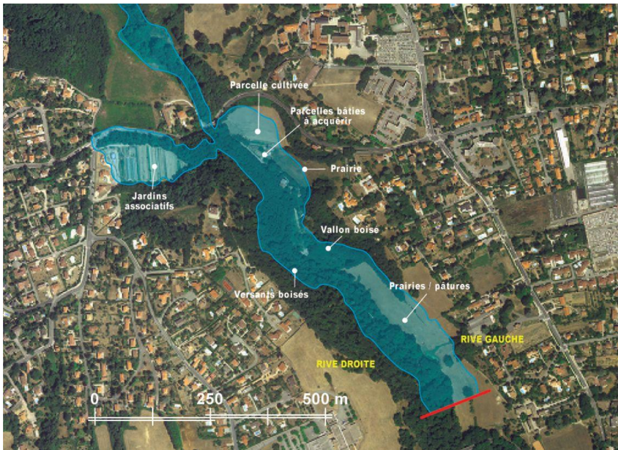
Figure 38 : Vue aérienne de la digue et de sa retenue, et illustration des usages actuels du site d'Alai à Tassin
