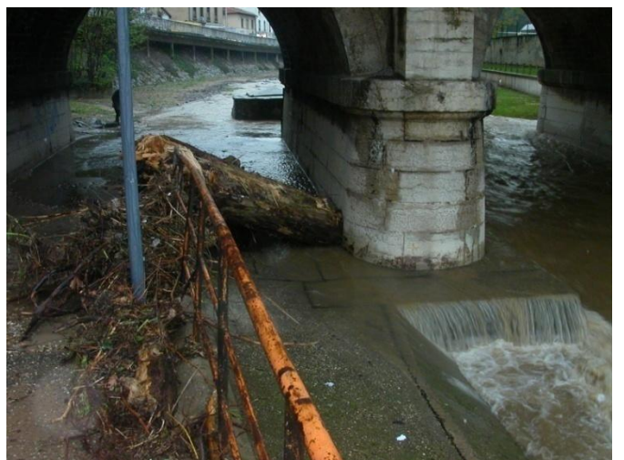
Photos 71 et 72 : Embâcle lors de la crue d'avril 2005 ayant détourné les écoulements sur le quai
